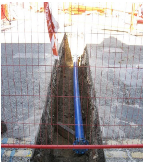
YW Springfield Ave/ Hilderthorpe Road 24/09/2016 14:29
